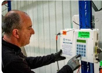
Les paramètres de l'aimant et les niveaux d'hélium sont surveillés et testés quotidiennement
